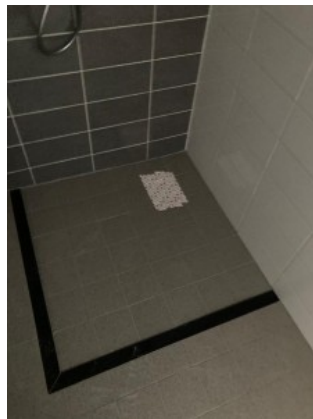
Afvoer douche afgetapet
