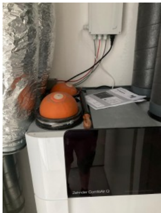
WTW afgekoppeld en kanalen afgedicht
