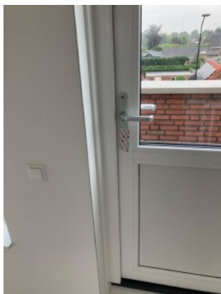
Sluitplaat achterdeur afgetapet
